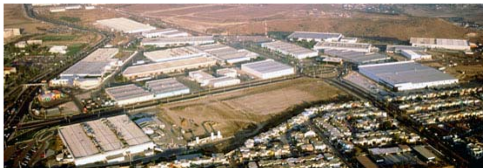
Suelo ocupado por actividades industriales en la zona este de la ciudad
