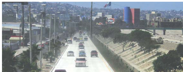
Vía Rápida, pavimentada con concreto hidráulico del programa PIRE 2008.
